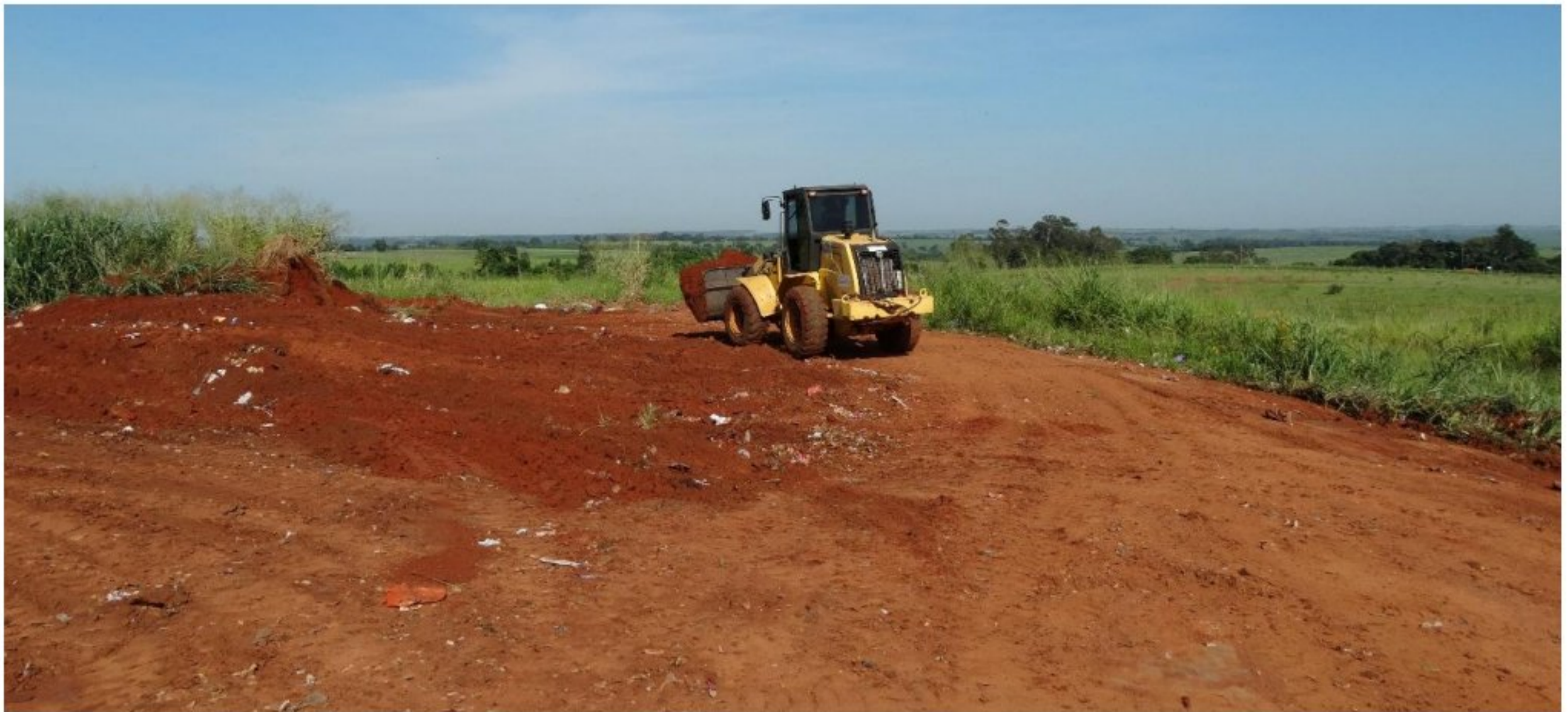
Imagem 19 – vista interna do aterro sanitário municipal de Salmourão, na ocasião de manutenção e cobertura de resíduos domiciliares.
