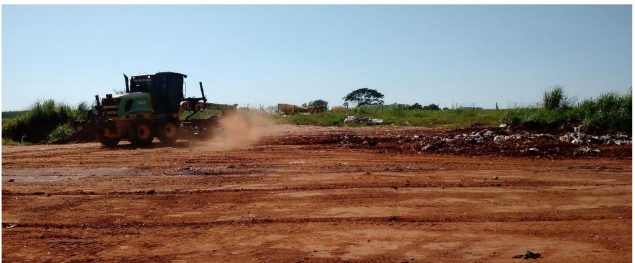
Imagem 21 – trabalho de manutenção de drenagens do aterro sanitário municipal de Salmourão.
