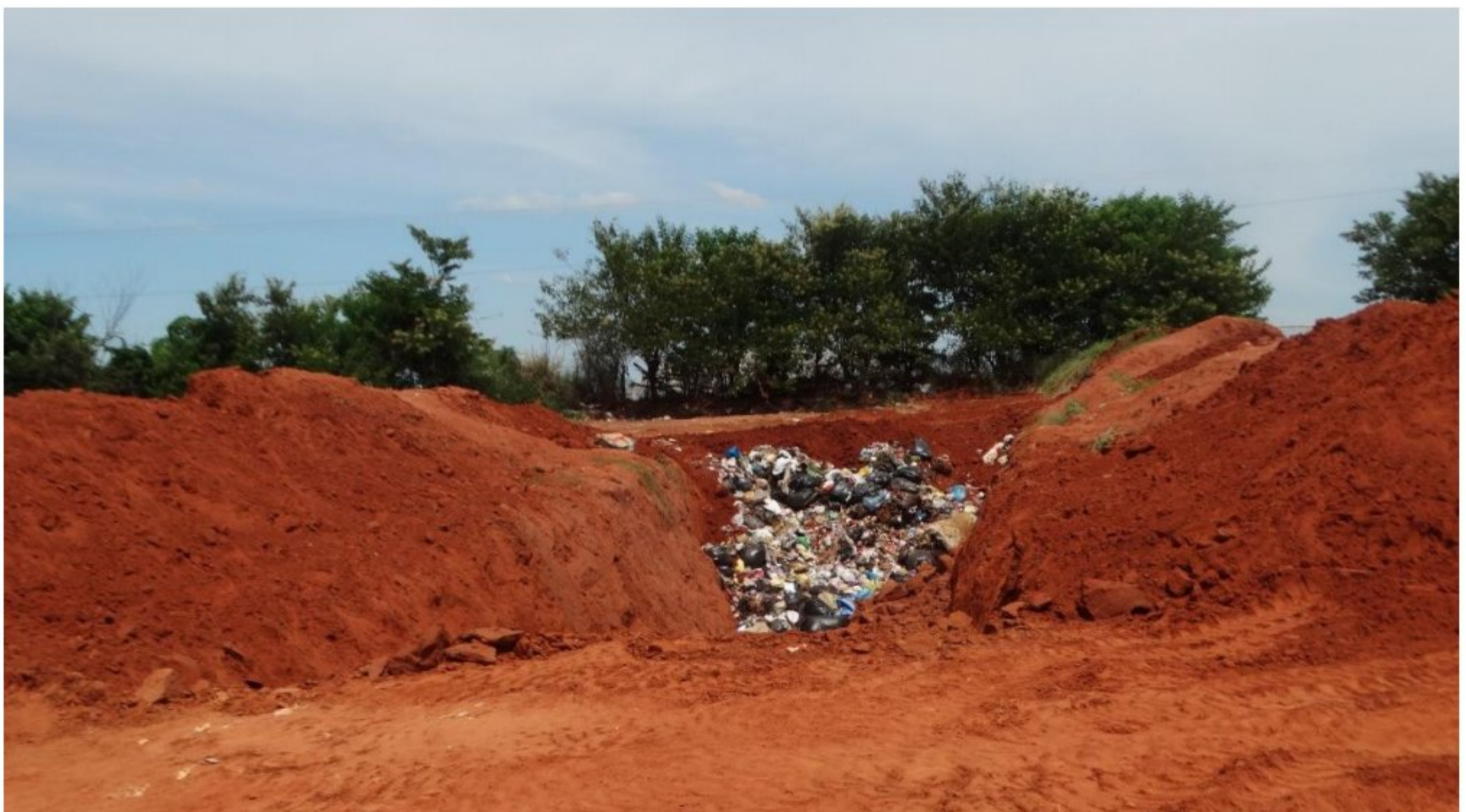
Imagem 20 – valas em operação do aterro sanitário municipal de Salmourão.
