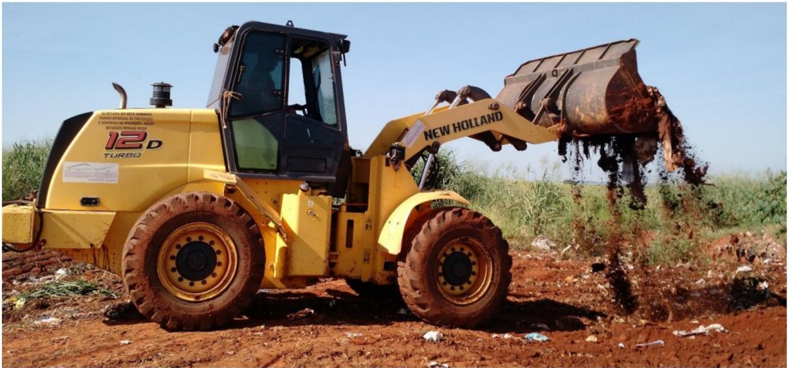
Imagem 22 – trabalho de manutenção de drenagens do aterro sanitário municipal de Salmourão.
