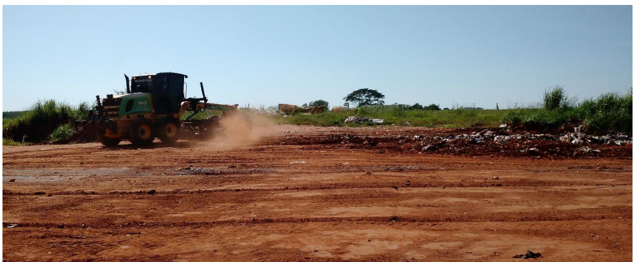
Imagem 22 – trabalho de manutenção de drenagens do aterro sanitário municipal de Salmourão.
