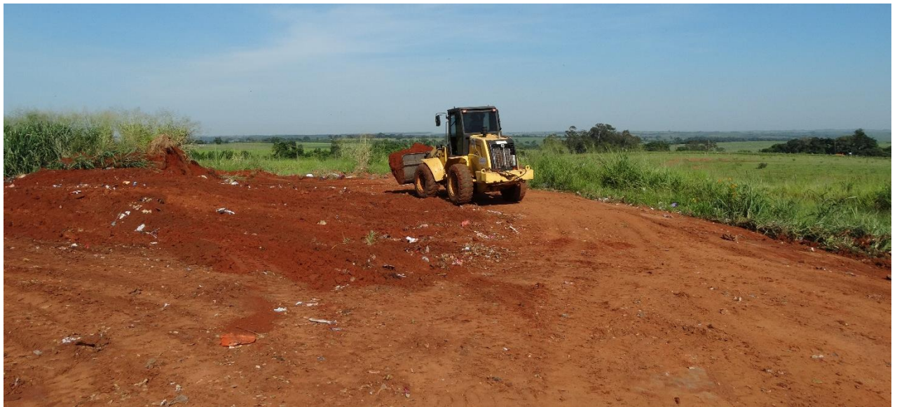
Imagem 20 – vista interna do aterro sanitário municipal de Salmourão, na ocasião de manutenção e cobertura de resíduos domiciliares.
