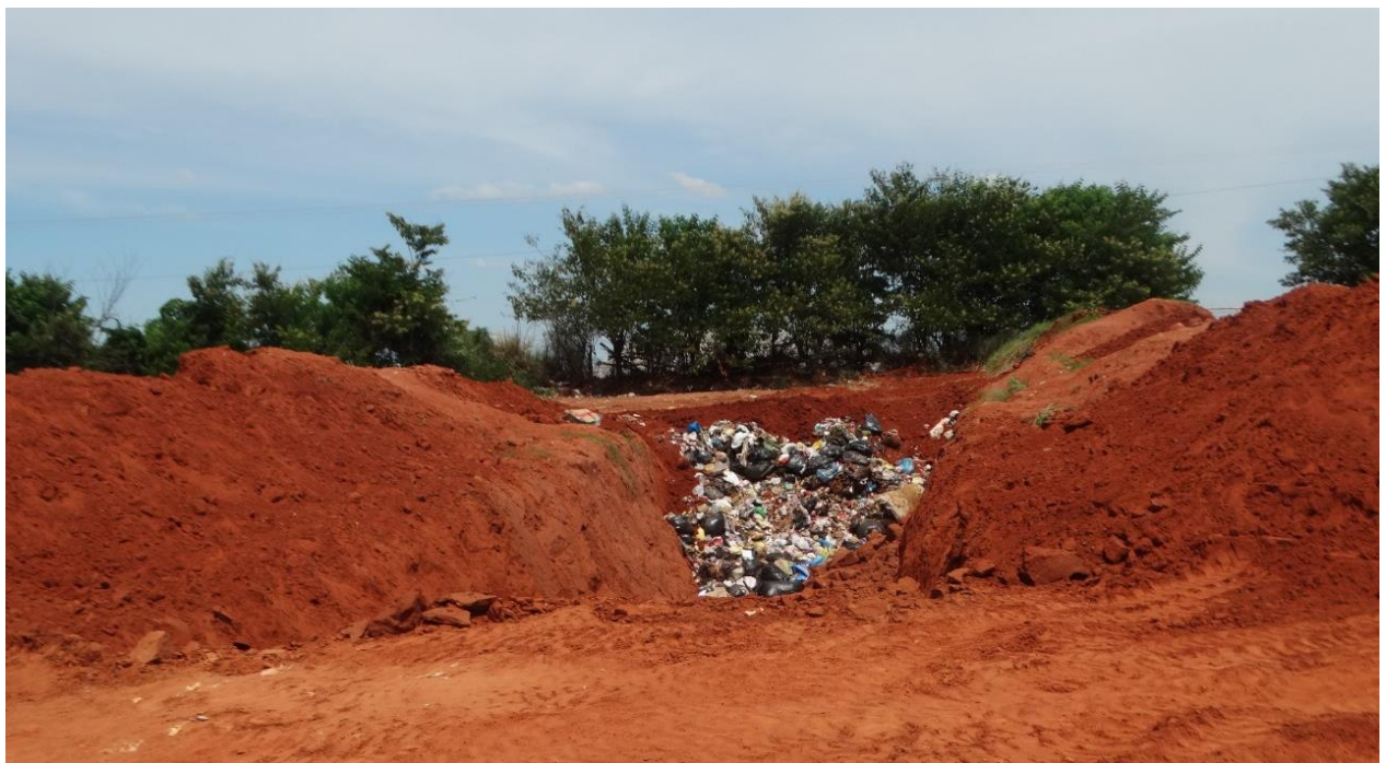
Imagem 21 – valas em operação do aterro sanitário municipal de Salmourão.
