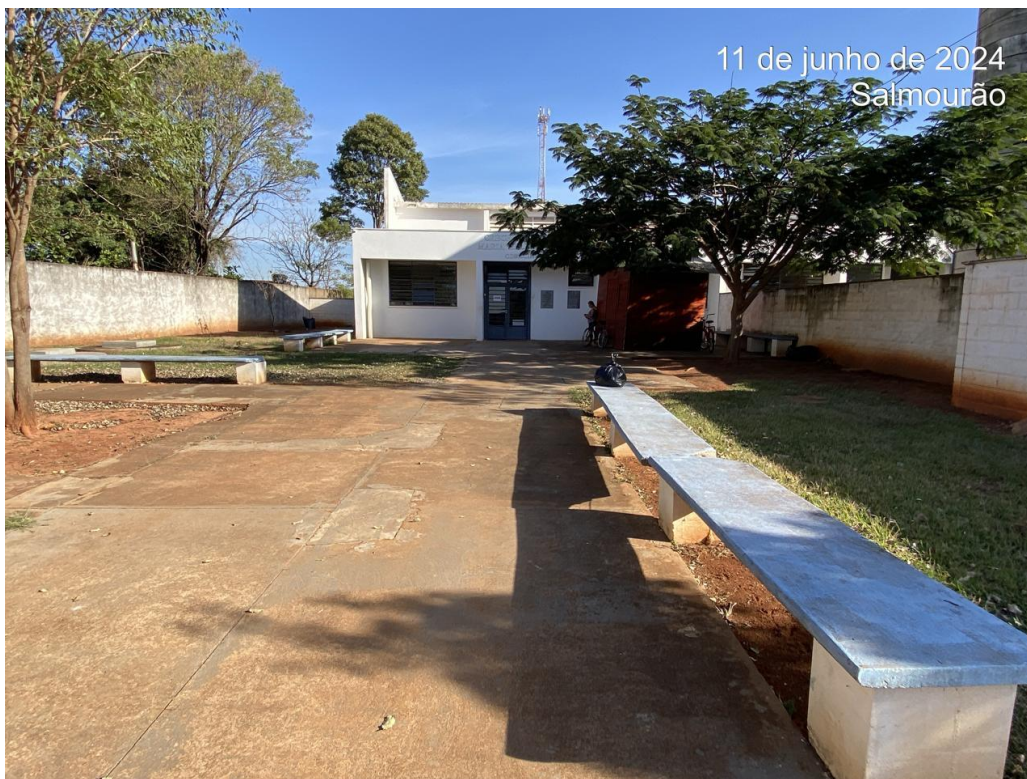
Foto 03 - Vista do local onde será construída a passarela
