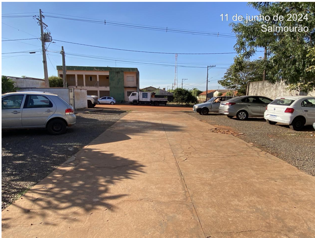
Foto 07 - Vista do local onde será construída a passarela
